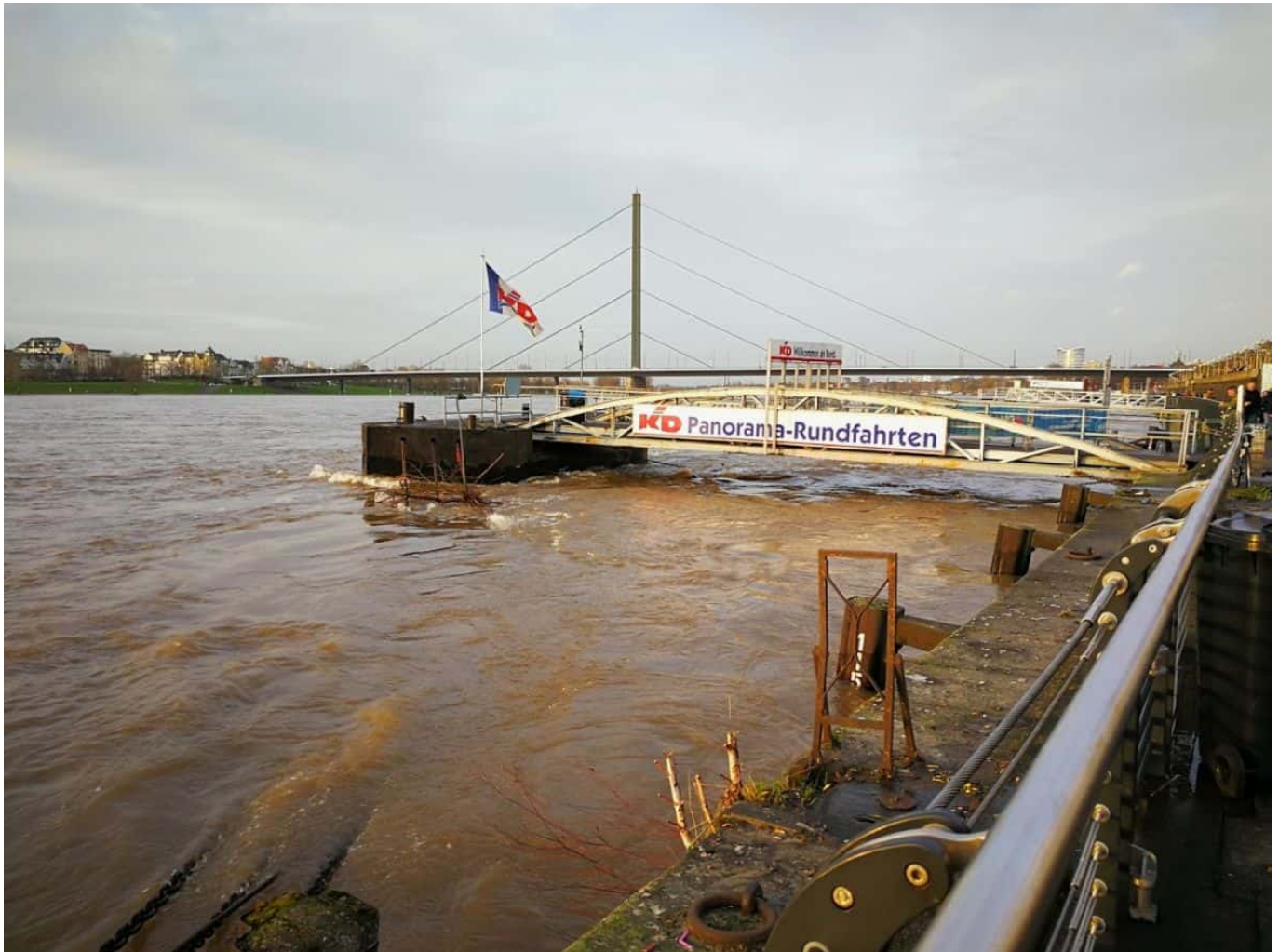
2018: Ein Steiger am Unteren Rheinwerft bei auflaufendem Hochwasser (Foto: TD)
