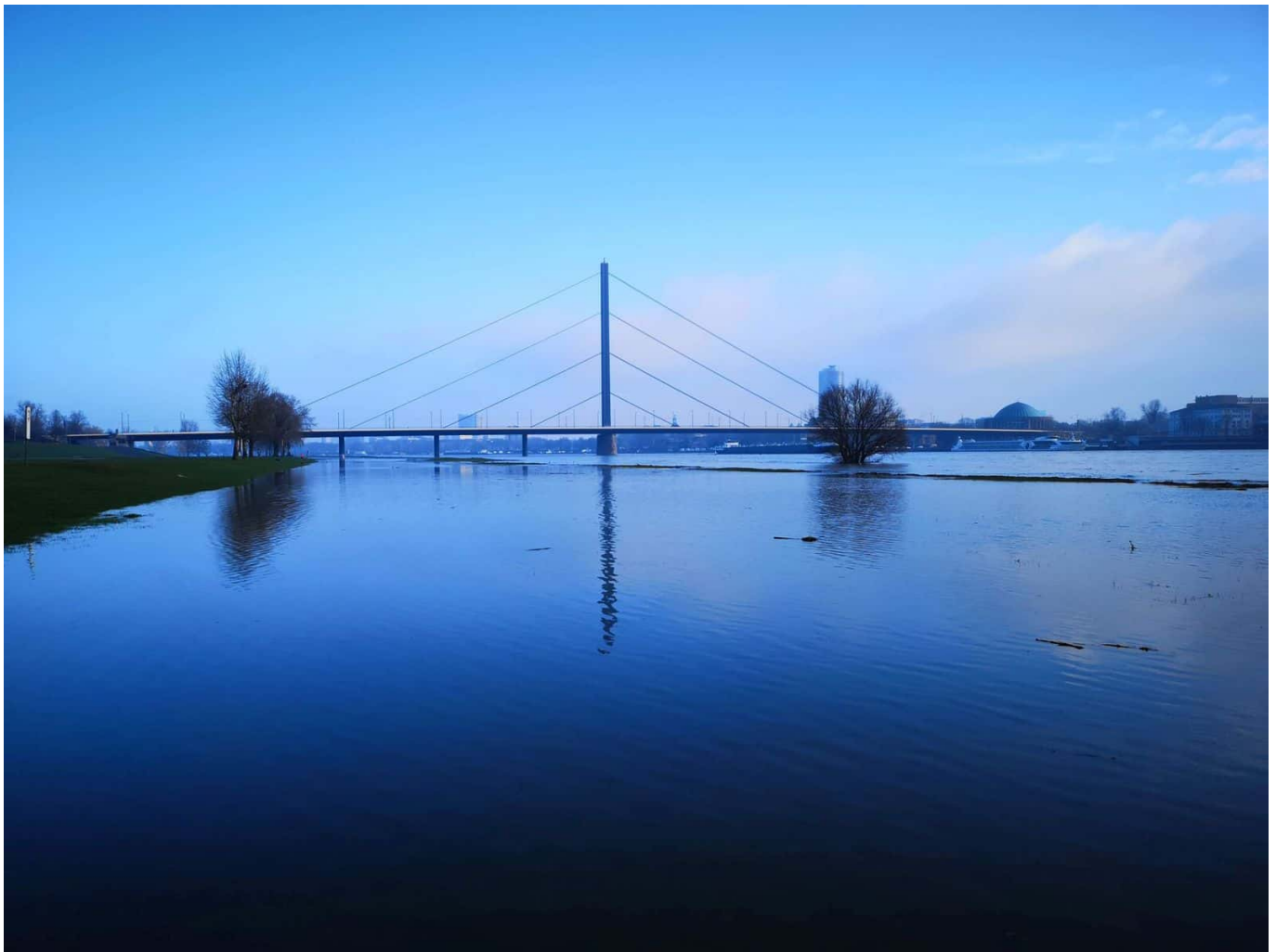
März 2020: Die Oberkasseler Brücke morgens bei Hochwasser (Foto: TD)
