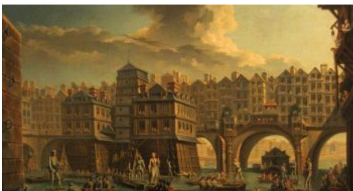
Brückenhäuser im alten Paris (Gemälde von Ragueneau)
