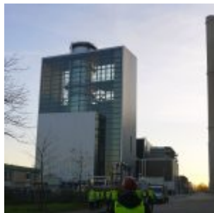
Deutschlands schönstes Kraftwerk: Block Fortuna auf der Lausward
