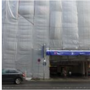
Abriss, Umbau, Neubau
