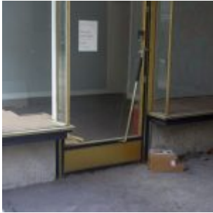
Leerstand vor Abriss
