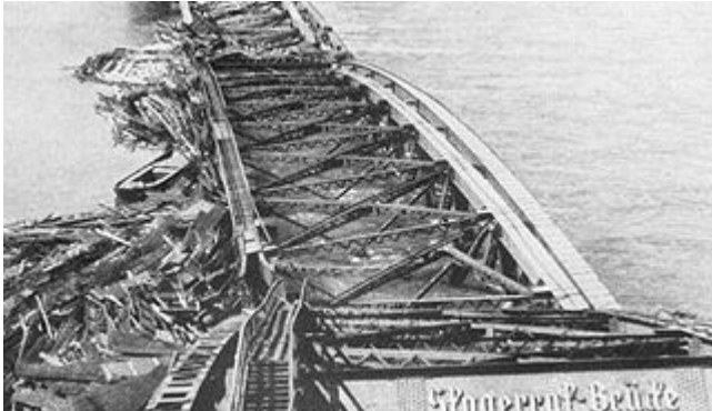
Die zerstörte Oberkasseler Brücke anno 1947
