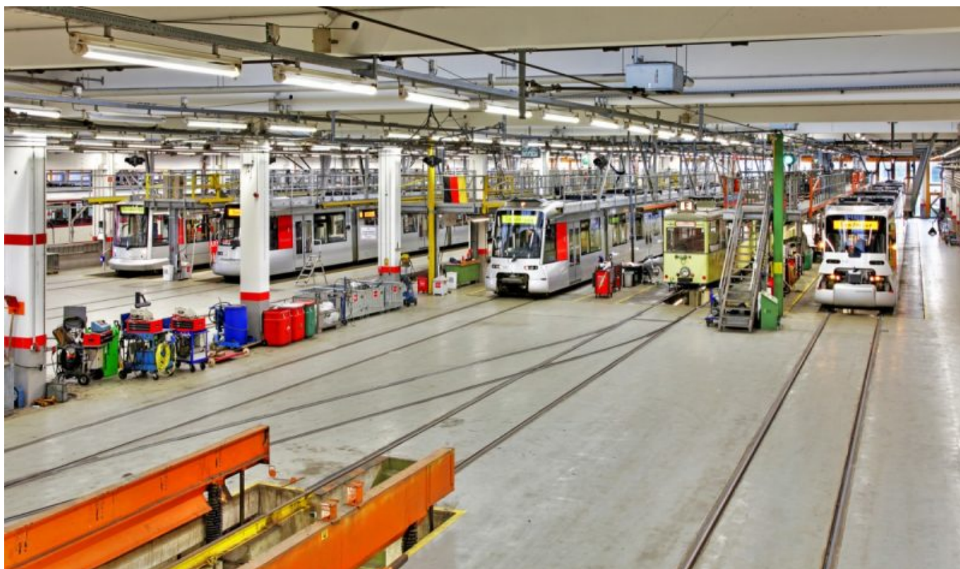
Die Straßenbahnwerkstatt im Betriebshof Lierenfeld (Foto: Rheinbahn)
