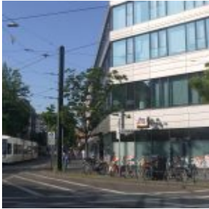
Eingang in die Nordstraße
