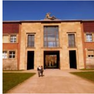
Der nördliche Eingang zum Ehrenhof
