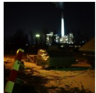
Blick auf die Müllverbrennungsanlage
