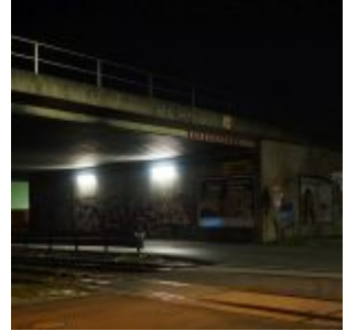
Die berühmte Unterführung
