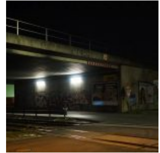
Die berühmte Unterführung
