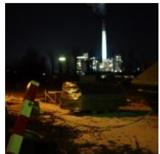
Blick auf die Müllverbrennungsanlage
