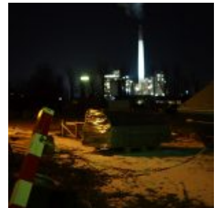
Blick auf die Müllverbrennungsanlage
