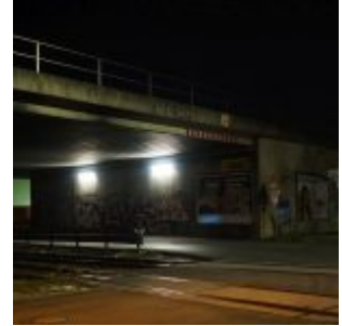
Die berühmte Unterführung
