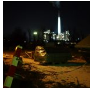
Blick auf die Müllverbrennungsanlage
