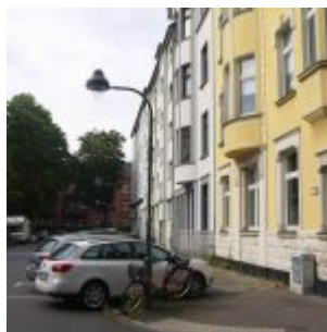
Blick entlang der Kanonierstraße
