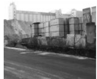
Deuka und Beton
