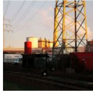
Am Kraftwerk Lausward
