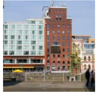
Ein ehemaliges Getreidesilo
