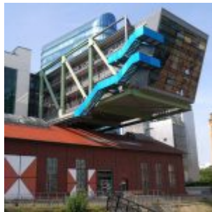
Ogilvy: Der Überbau
