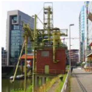
Relikt am Getreide-Silo
