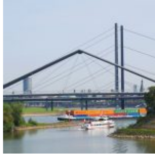
Fußgängerbrücke über die Hafeneinfahrt (Foto: TD)
