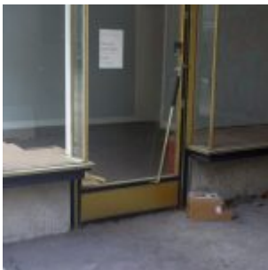
Leerstand vor Abriss
