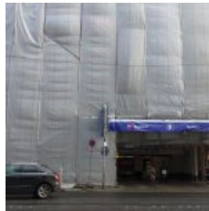
Abriss, Umbau, Neubau
