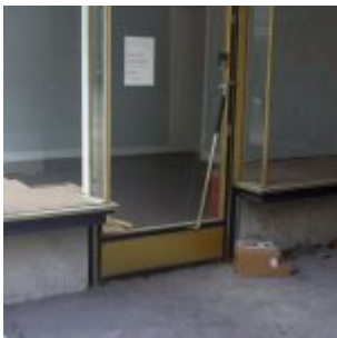
Leerstand vor Abriss
