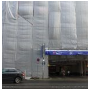
Abriss, Umbau, Neubau
