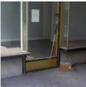
Leerstand vor Abriss
