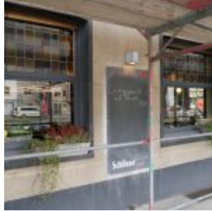
„Hirschchen“ – zur Zeit Baustelle
