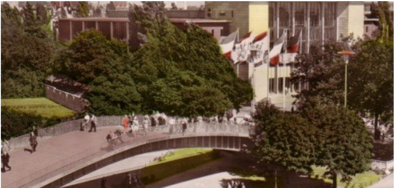
DQ93: Die Aluminiumbrücke zwischen (alter) Messe und Rheinterrasse
