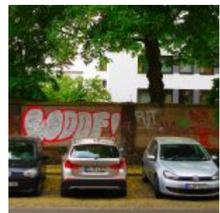
Kleiner Rest der alten Krankenhausmauer
