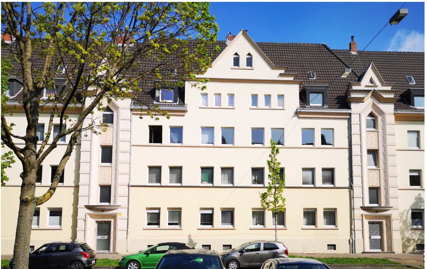
Eines der schönen Mietshäuser an der Schlesischen Straße (Foto: TD)
