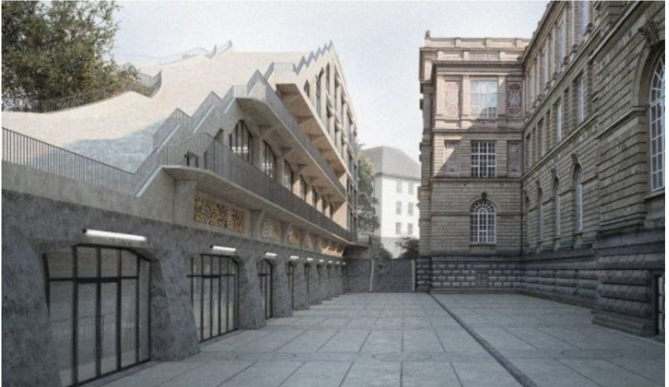
Anbau der Kunstakademie: rechts der alte Bau, links der Anbau (Foto: Kunstakademie)
