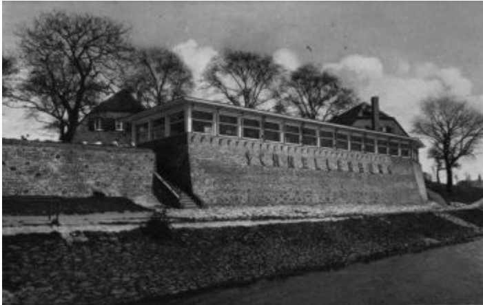
Die neue Schnellenburg in den Dreißigerjahren
