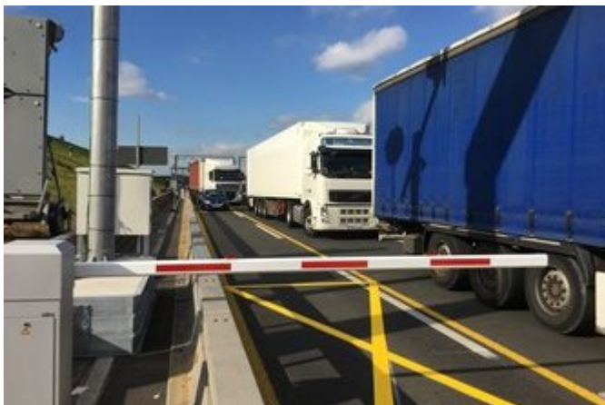
Schrankenanlage an der Leverkusener Autobahnbrücke (Quelle: www.strassen.nrw.de )
