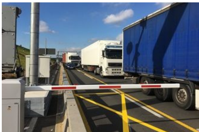
Schranksanlage an der Leverkusener Autobahnbrücke (Quelle: www.strassen.nrw.de )
