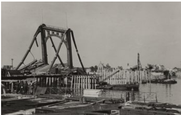
Die 1945 eingestürzte Deutzer Brücke (Foto: sehenswuerdig.koeln.de )
