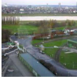
Blick auf die Einfahrt zum Kraftwerksgelände
