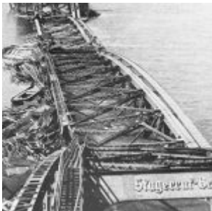
Die gesprengte Skagerrak- Brücke (Oberkasseler Brücke) 1945
