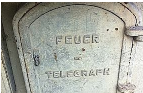
Diesen Feuertelegraph an der Ecke Kaiserswerther/Uerdinger Straße fotografierte unser Leser Andy im Sommer 2011
