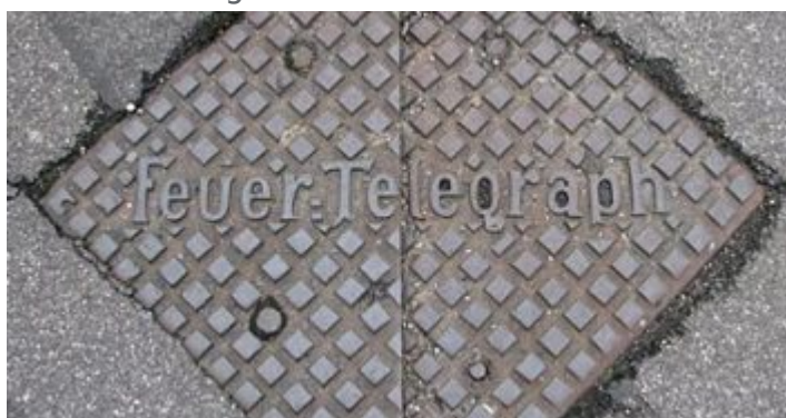
Ein versenkter Feuertelegraph in Köln (fotografiert 2008 von O. Mensch via deckelschau.de)
