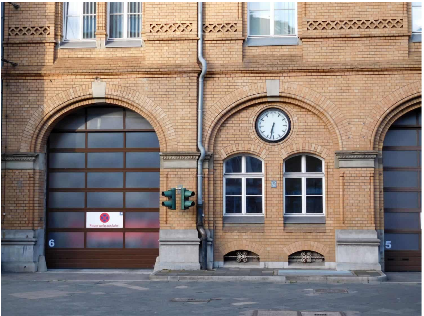
Die Feuerwache I an der Hüttenstraße im Jahr 2019 (Foto: TD)
