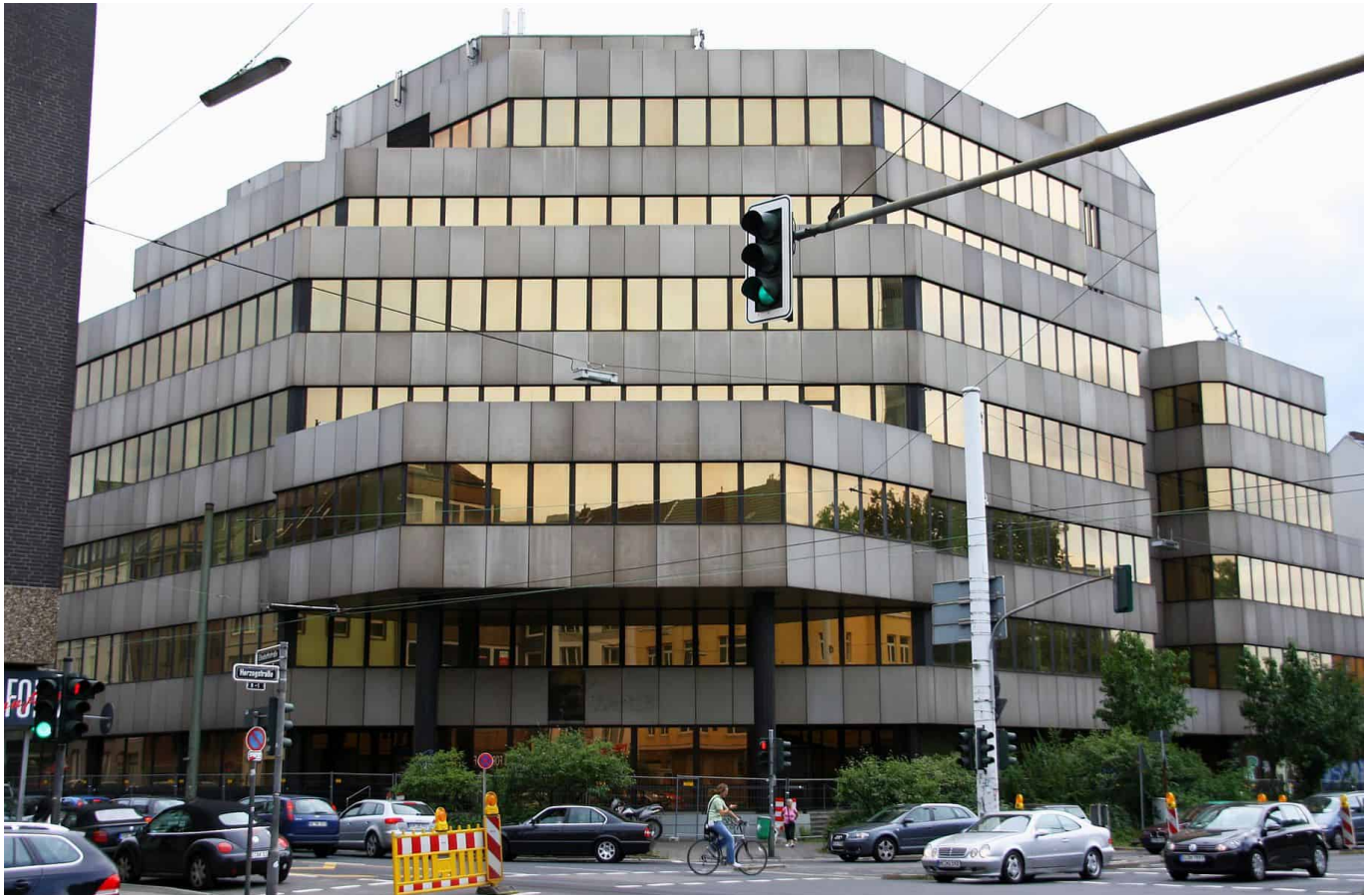
2009: Ein ehemaliges Gebäude der WestLB an der Elisabethstraße wird kernsaniert und umgenutzt (Foto: TD)
