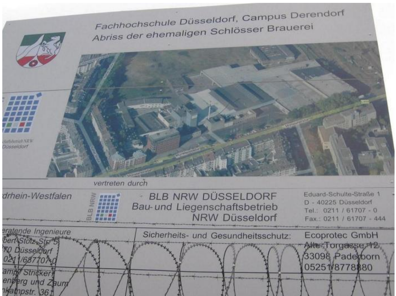
Abriss der Schlösser-Brauerei an der Münsterstraße (Foto: TD)
