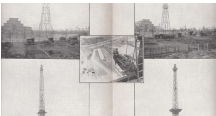
Der Berliner Funkturm in Bau – eine Konstruktion der Hein, Lehmann von 1928
