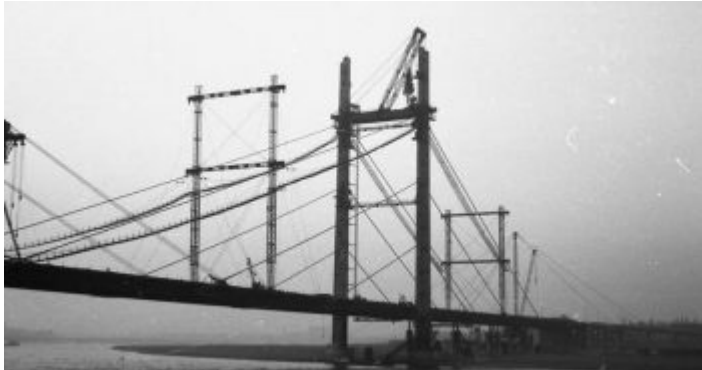
Die Kniebrücke im Bau – ein Hein-Lehmann-Projekt
