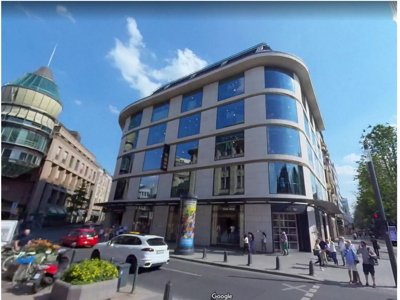
Und so sieht der Komplex heute aus (Screenshot Google Streetview)
