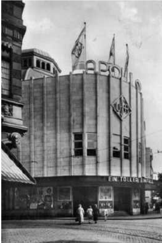
So sah das Apollo-Theater nach der Radikalsanierung 1931 aus (Foto via allekinos.com)
