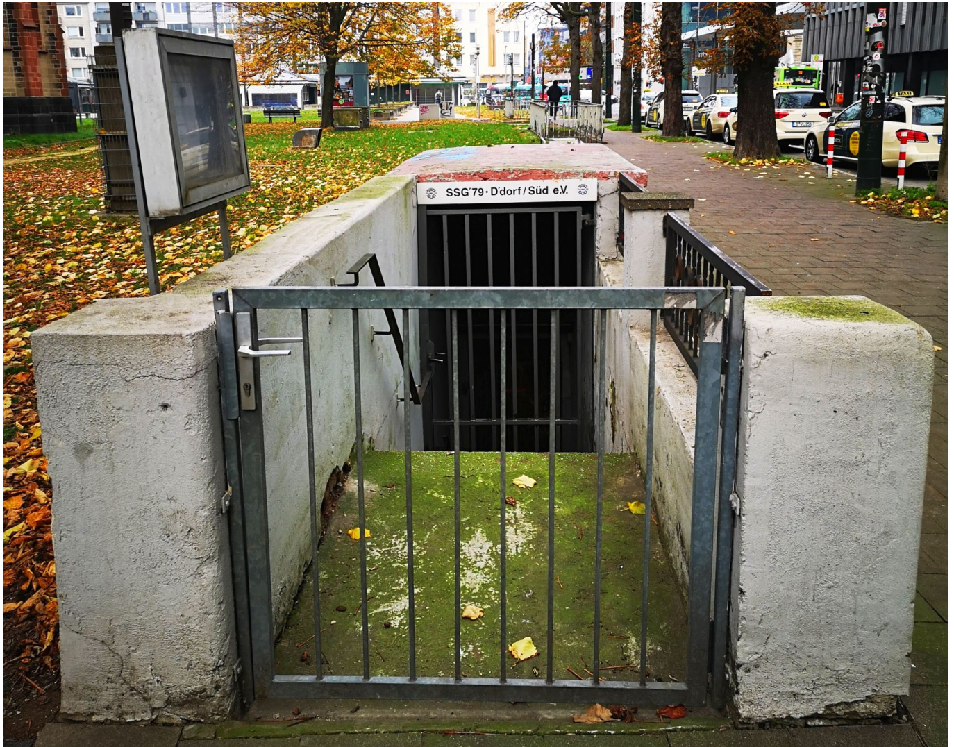
2021: Hier geht's runter zur SSG-Anlage am Kirchplatz (Foto: TD)
