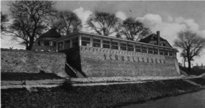
Die neue Schnellenburg in den Dreißigerjahren
