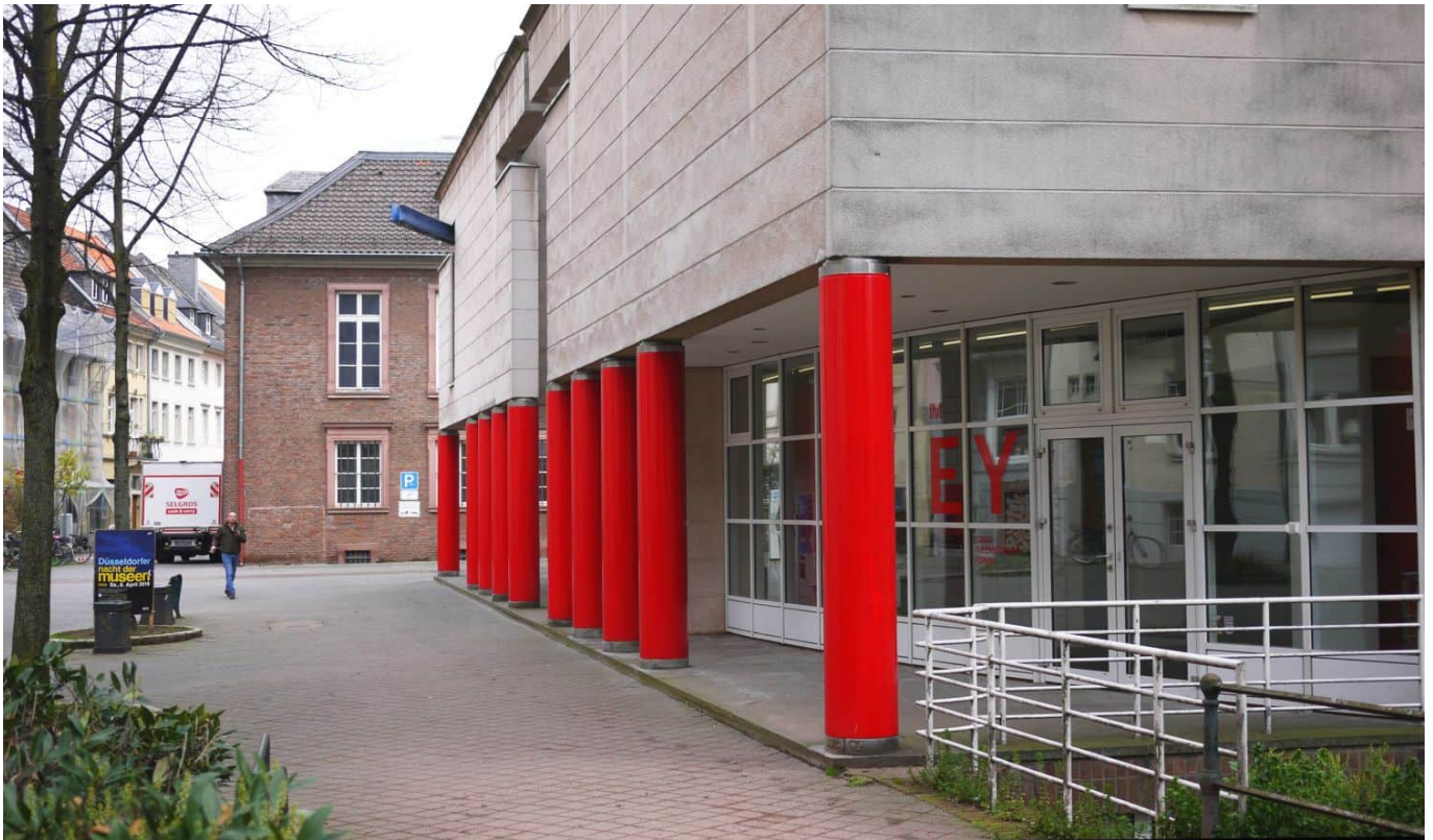
Die Fassade des Erweiterungsbaus an der Berger Allee
