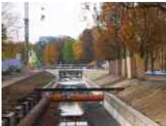
Die freigelegte Düssel
