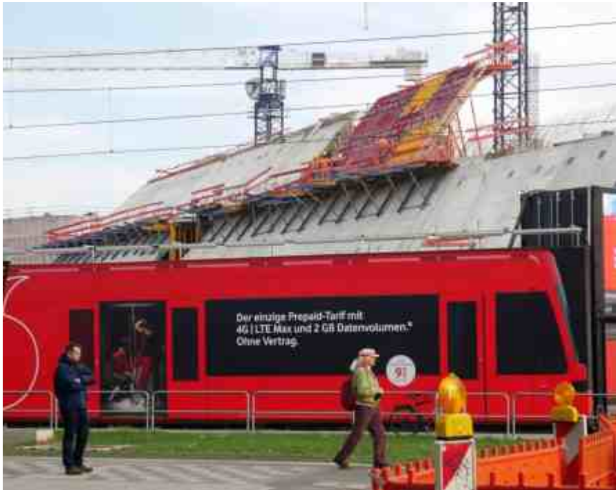
Ansicht der Großbaustelle
