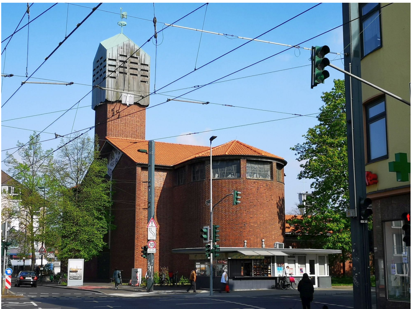
Die Michaelskirche am ÖPNV-Knotenpunkt Schlesische Straße (Foto: TD)
